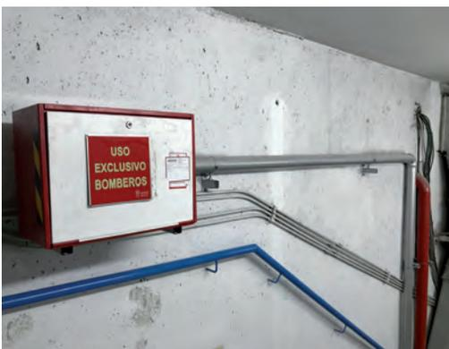
Familiarizarse con el uso de las columnas secas, permite a las dotaciones de bomberos rapidez en la realización de instalaciones de agua y extinción del incendio.
