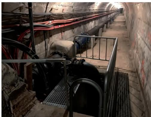
Existen pozos que realizan interconexiones con otras galerías a distinto nivel y que permite la bajada de los operarios mediante pates metálicos.
