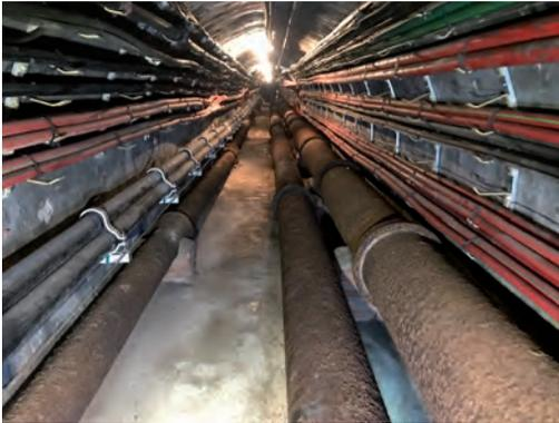
Una galería de servicio es una construcción subterránea, de sección variable y visitable, y en el que se alojan una serie de conducciones o redes correspondientes a los servicios que una gran ciudad necesita.
