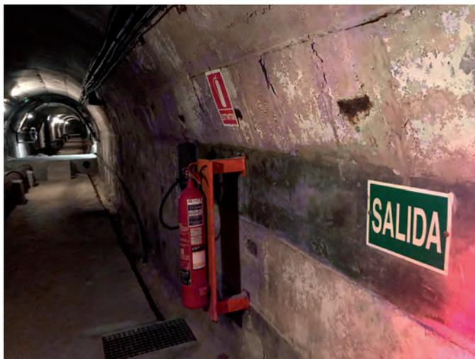
Las galerías de servicio están dotadas de, comunicación por medio de postes SOS, extintores portátiles y recorridos de evacuación señalizados, para su utilización en caso de emergencia.
